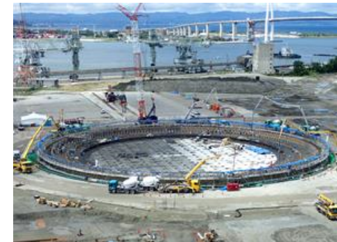
〔LNGタンク コンクリート打設〕
