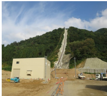
〔建設工事中の片貝別又発電所〕
