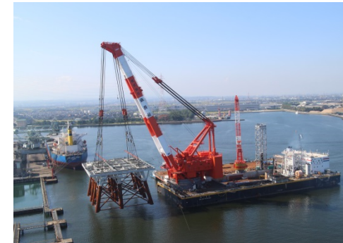
〔LNGバース工事〕
