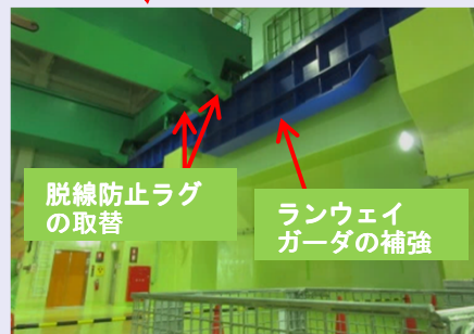
〔天井クレーン〕
