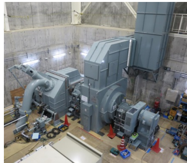
〔組立中の水車発電機〕
