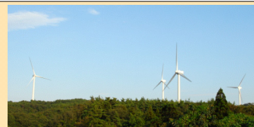
運転開始した福浦風力発電所
