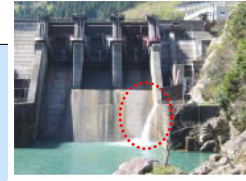
河川維持放流の状況(仏原ダム)
