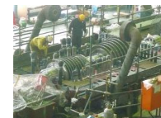
タービンロータの据付状況
