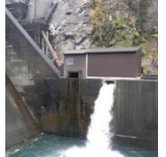
仏原ダム発電所 (河川維持放流水を活用した発電所)
