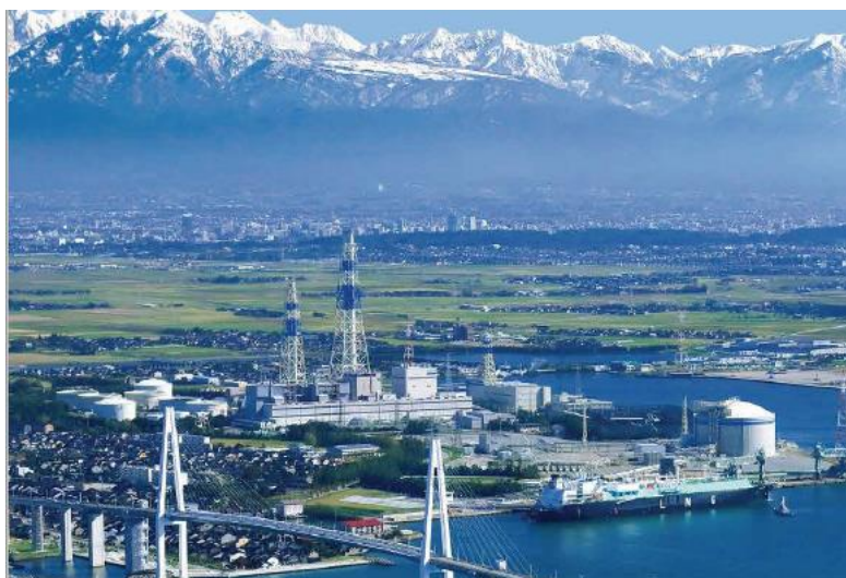
富山新港火力発電所
