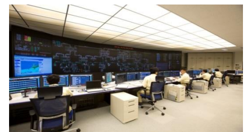
給電指令による需給調整の様子
