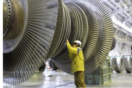
火力発電所定期点検工事の様子
