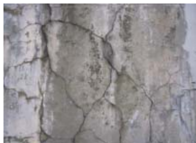
写真 1 ASR が発生したコンクリート
