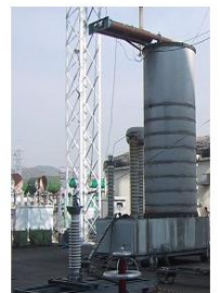
図3 インパルスジェネレータを使用した制限電圧測定
