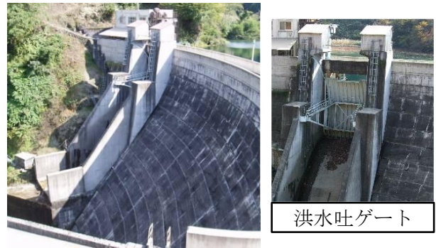
第 2 図 小原ダム全景
