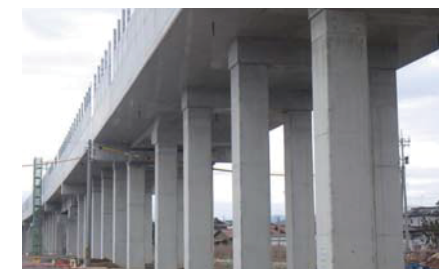
北陸新幹線高架橋
