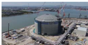
LNGタンク PC防液堤
