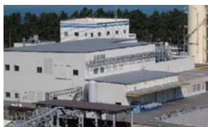
変圧器リサイクルセンター
