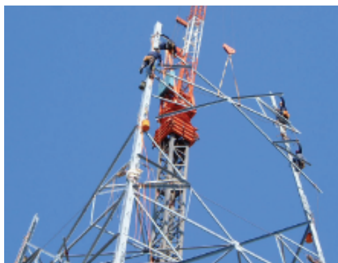
鉄塔組立工事
