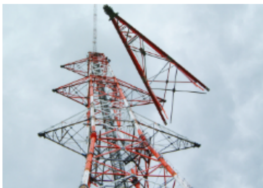
大型クレーンを用いた鉄塔組立工事
