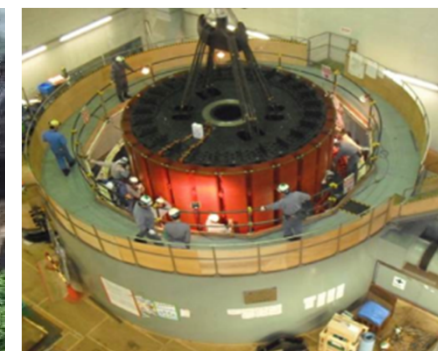
水車発電機のオーバーホール
