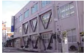
北陸電力小松支社(耐震補強)
