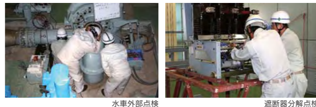
水車外部点検
