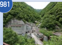
有峰第一発電所(水力)
