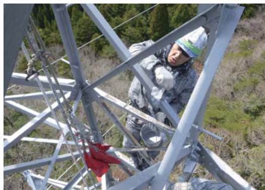
設備延命化に向けた鉄塔の塗装
