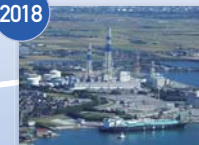
富山新港火力発電所 LNG1号機
