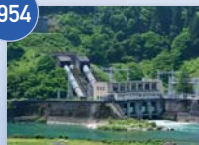
神通川第一発電所(水力)
