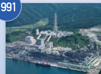
敦賀火力発電所1号機
