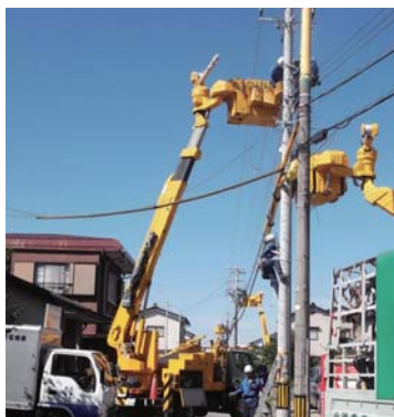
コンクリート柱の建替工事
