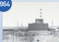
富山火力発電所1号機
