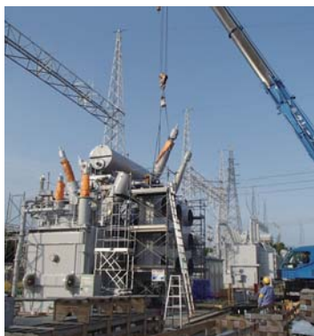
大型変圧器更新工事
