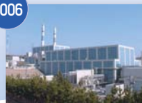
志賀原子力発電所2号機
