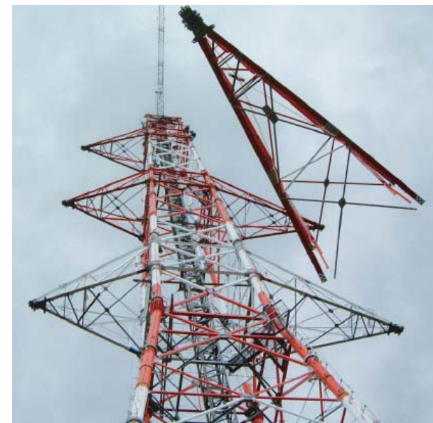
鉄塔組立工事
