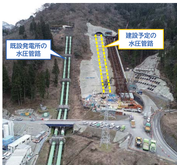
新姫川第六発電所の建設状況(2020年1月)
