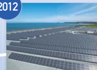
三国太陽光発電所
