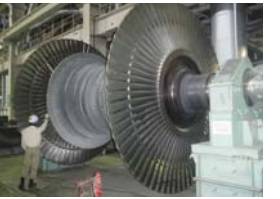
火力発電所定期点検の様子
