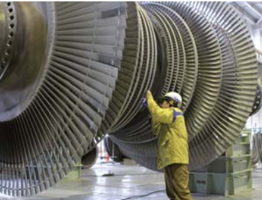
火力発電所定期点検工事の様子
