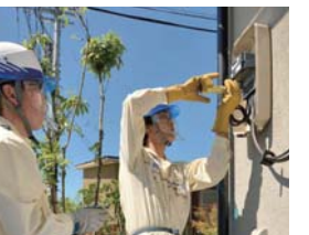
スマートメーター設置の様子
