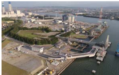
LNG基地全景
