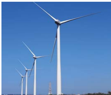
運転開始した三国風力発電所
