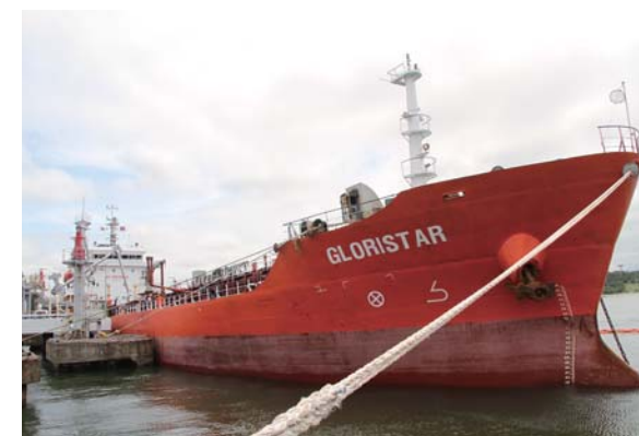
福井火力発電所での外航船直接受入風景
