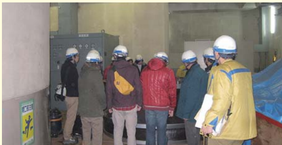
新猪谷発電所見学会の様子
