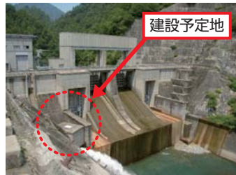
北又ダム発電所建設予定地
