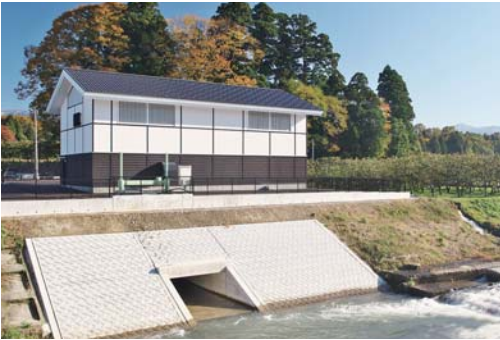
山田新田用水発電所(放水口側)
