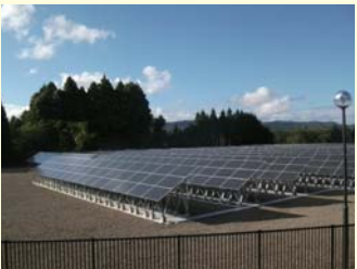
珠洲太陽光発電所の建設工事
