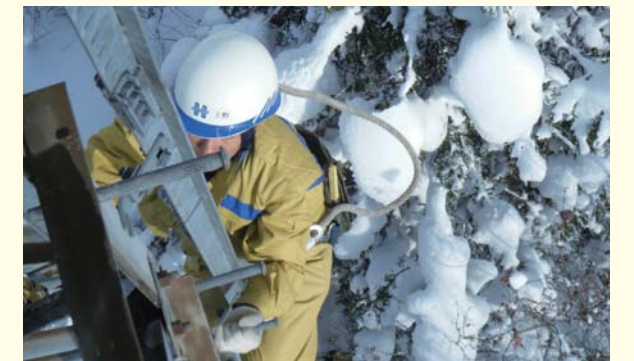
鉄塔昇塔訓練
