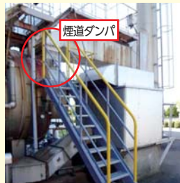
煙道ダンパを安全に操作するため、ハシゴを撤去し、階段を設置
