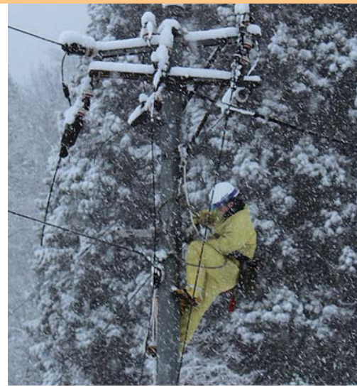
厳冬期での断線復旧訓練
