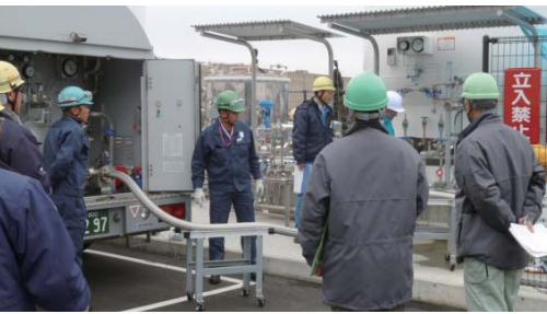
サテライト設備へのLNG荷卸作業
