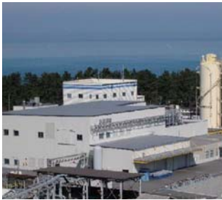
変圧器リサイクルセンター
