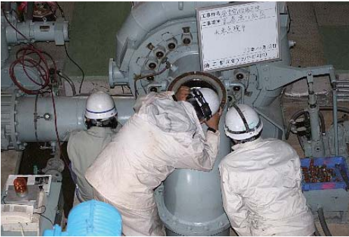
小水力発電所の水車外部点検作業
