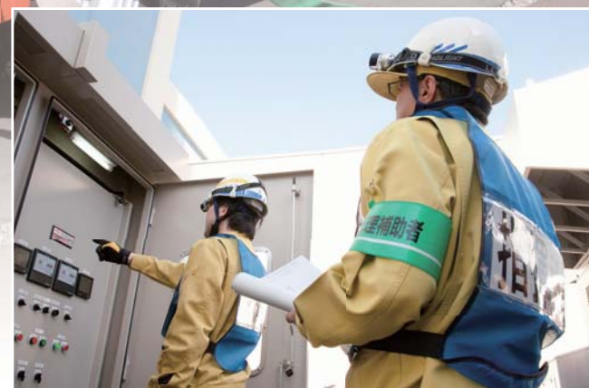
大容量電源車による給電訓練
