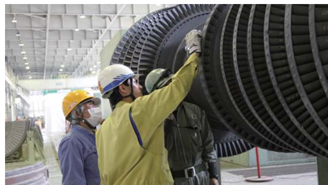
火力発電所タービン点検
