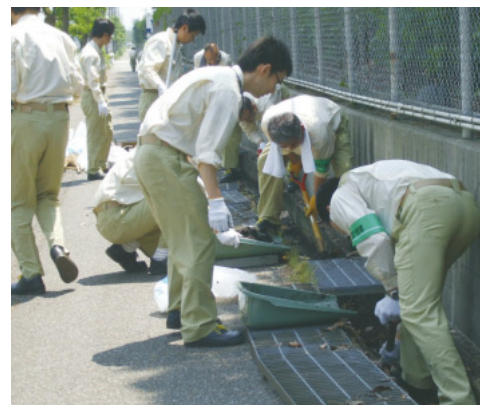
国道の側溝清掃の様子(富山新港火力発電所)
