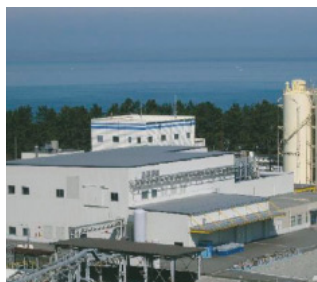
変圧器リサイクルセンター
