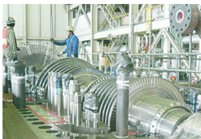
高中圧タービンロータ取付状況
