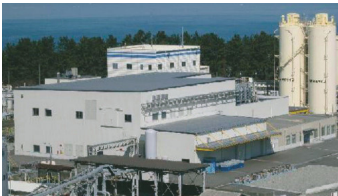
変圧器リサイクルセンター
