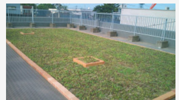
小松支社屋上に設置した緑化材
