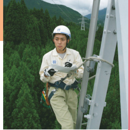
送電線巡視による樹木離隔距離の確認
