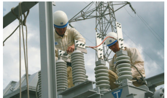
移動変圧器設営研修
