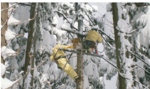
積雪時の配電線、送電線事故に備える雪中訓練
