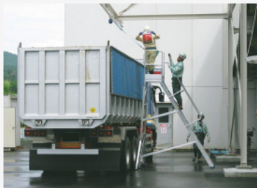
設備設計にリスクアセスメント結果を反映(荷台上部に安全帯を取付できる親綱を設置)
