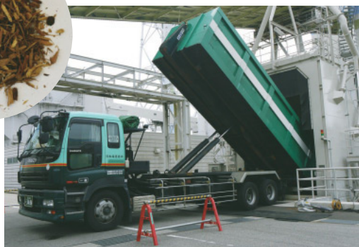
木質バイオマスの受入れ(七尾大田火力発電所)
