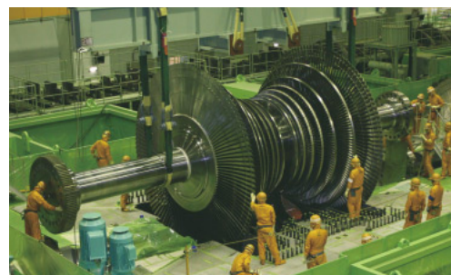
新翼(低压タービンロータ)への取り替え
