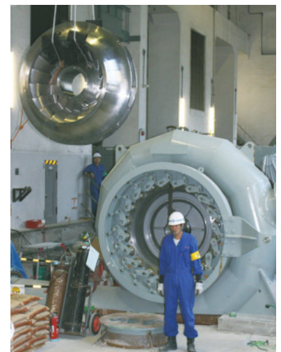
尾口発電所1・2号発電機取替
