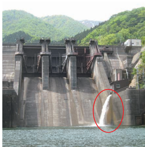
河川維持放流の状況（仏原ダム）
