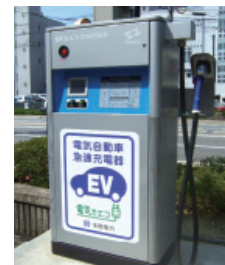
急速充電装置
