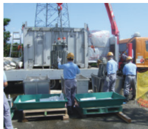
高濃度PCB機器搬出作業
