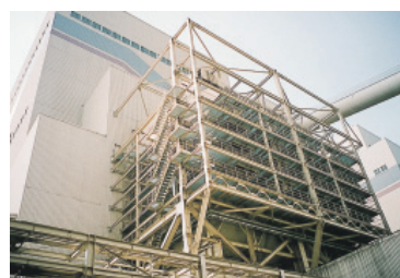
排煙脱硝装置(敦賀火力発電所)
