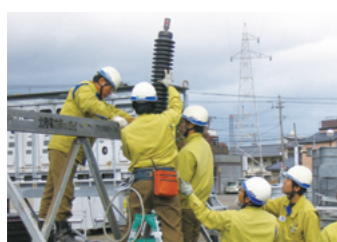
移動用設備設営訓練
