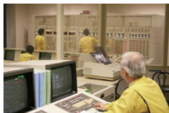
火力運転シミュレータ訓練
