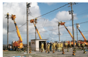
配電工事安全技能大会
