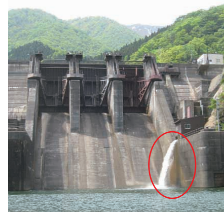
河川維持放流の状況(仏原ダム)
