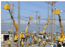
配電工事安全技能大会
