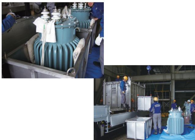
高濃度 PCB 機器搬出作業
