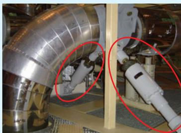
1号機主蒸気配管への防振器の追加
