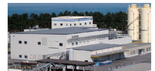
絶縁油リサイクルセンター
