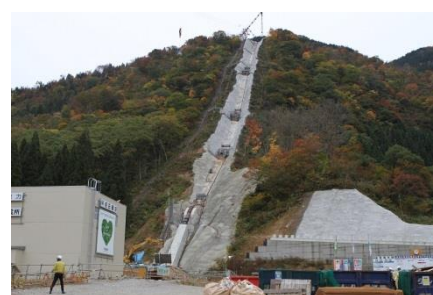
片貝別又発電所建設工事現場
