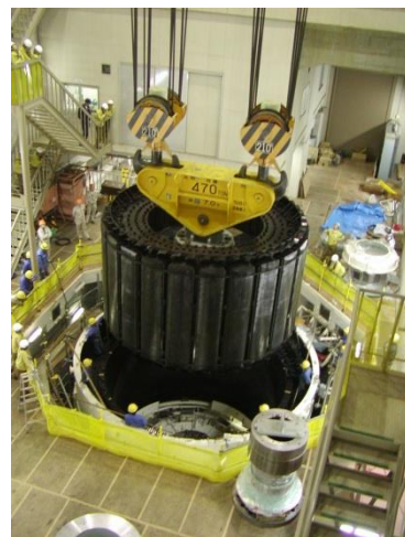
有峰第一発電所 前回オーバーホールの様子
