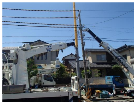
コンクリート柱建替工事の様子
