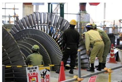
敦賀火力発電所 2号機定期点検の様子
