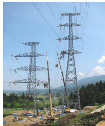
鉄塔建替工事の様子
